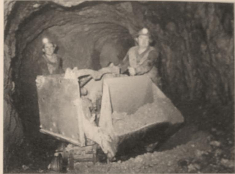
*Chargement du minerai à l'aide d'une pelle Eimco à air comprimé sur rails dans une recoupe du niveau 200, 1959. (photo C. Gagnard)*
