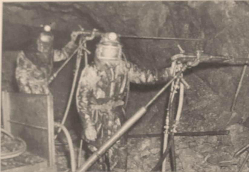
*Foration dans un chantier très riche, niveau 56 du Tronçon Central, 1960. Les mineurs sont équipés d'un masque alimenté en air pur afin de limiter l'ingestion des poussières radioactives. (photo C. Gagnard)*
