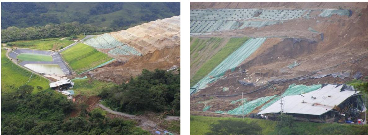
Figure 35 : Conséquences de l'effondrement d'un tas lixivie en 2007, mine d'or de Bellavista, Costa Rica (CEUS del Golfo · Janvier 2009 · cc by-sa-nc 2.0)
