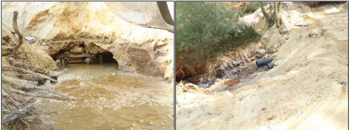
Illustration 17 - Vue des galeries d'exhaures et vue des canalisations après travaux.
