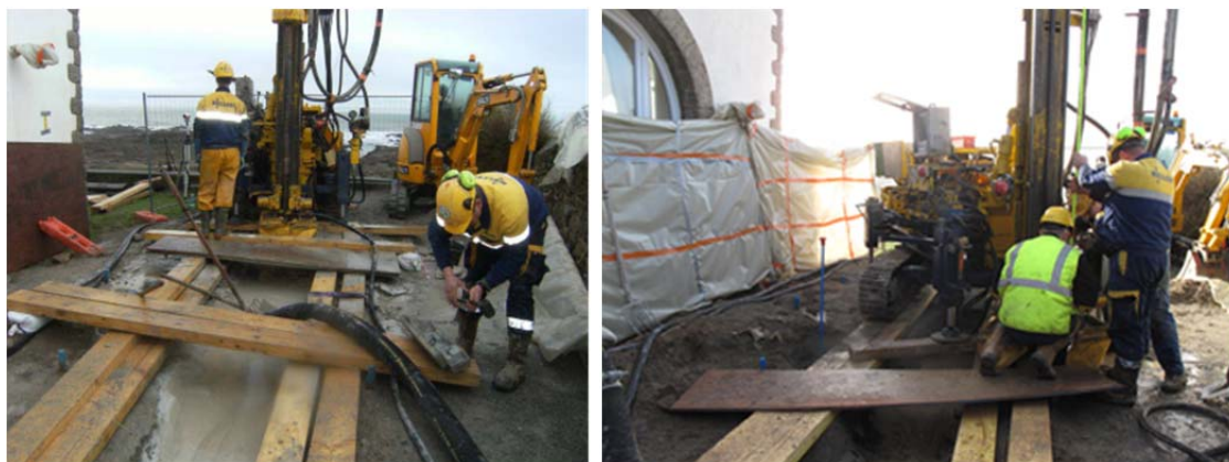
Illustration 12 - Forage et injection des colonnes.
