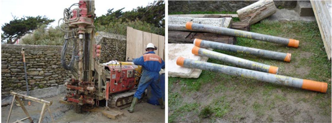
Illustration 13 - Vue du carottage vertical entre les colonnes des carottes.
