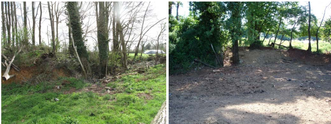
Illustration 8 - Vue du puits Avaloup avant et après les travaux.
