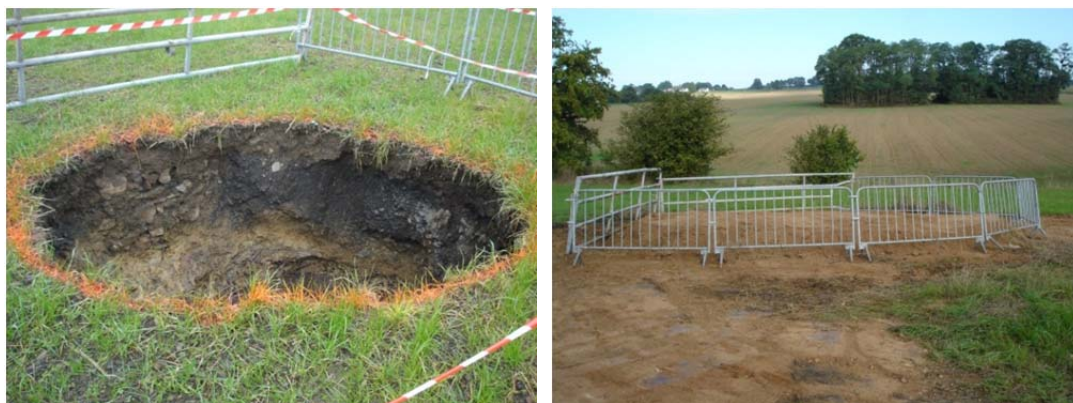
Illustration 11 - Vue du puits Bouly avant et après les travaux.
