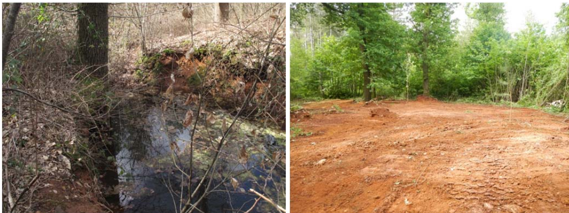
Illustration 9 - Vue du puits Grasimond avant et après les travaux.
