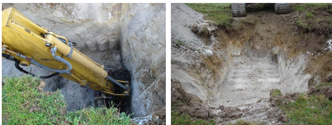
Illustration 15 - Excavation et comblement du fontis du Bé.
