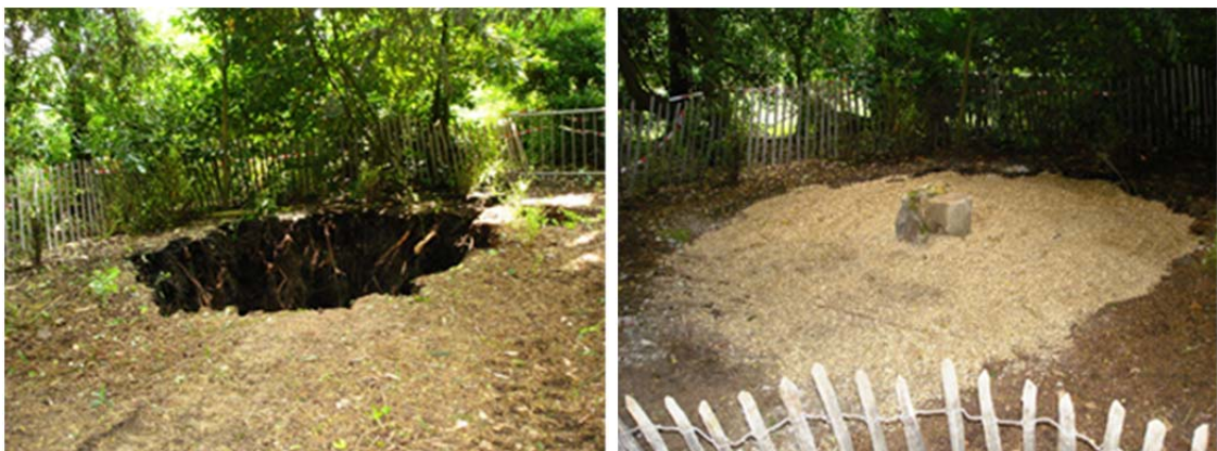
Illustration 14 - Vue du puits du Vallon avant et après les travaux.
