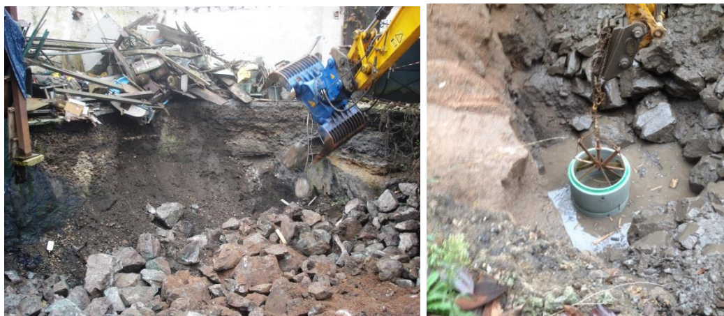
Illustration 16 - Enrochement du cratère et pose de la buse diamètre 1 000 mm.
