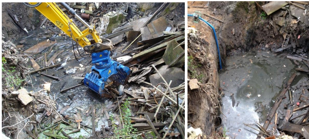
Illustration 15 - Vue de l'excavation des déchets et du pompage de l'eau.
