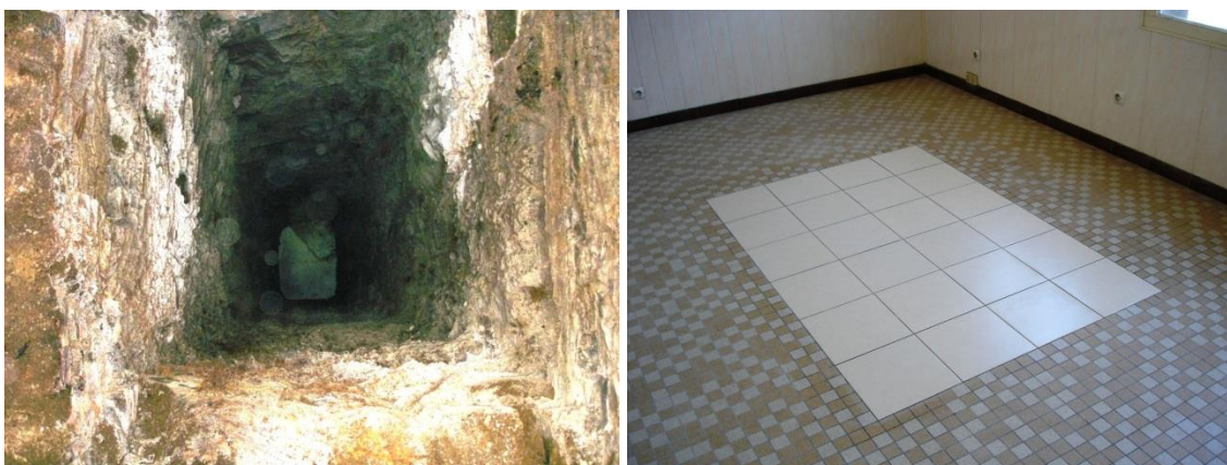
Illustration 9 - Vue du puits Saint-Antoine pendant et après les travaux.
