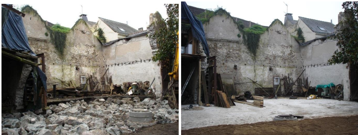
Illustration 17 - Vue de la dernière couche d'enrochement et du bétonnage final.
