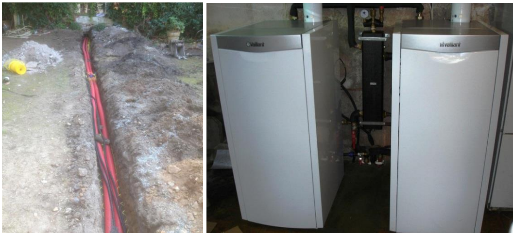
Illustration 14 - Vue de la pose du réseau et des chaudière.
