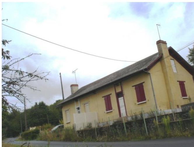
Illustration 12 - Vue des deux logements (maison mitoyenne).
