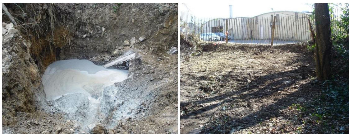
Illustration 11 - Vue du puits Saint-Jean après travaux.
