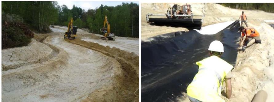
*Illustration 18 : Façonnage du chenal et pose de la géomembrane étanche.*
