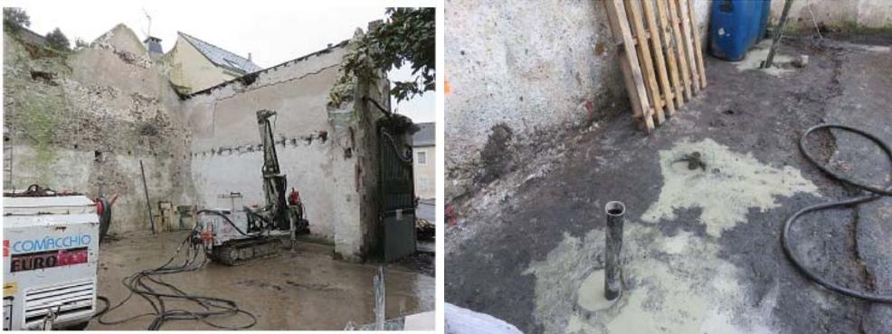
*Illustration 10 : Vue des forages, des injections et des injections saturées en coulis.*
