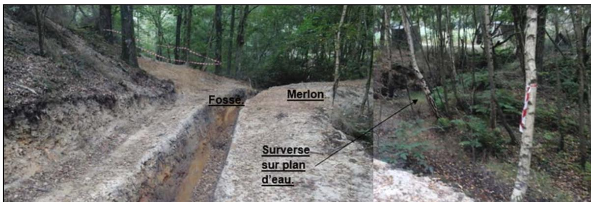
Illustration 29 : Séparation des eaux de ruissellement et de la surverse du plan d'eau.
