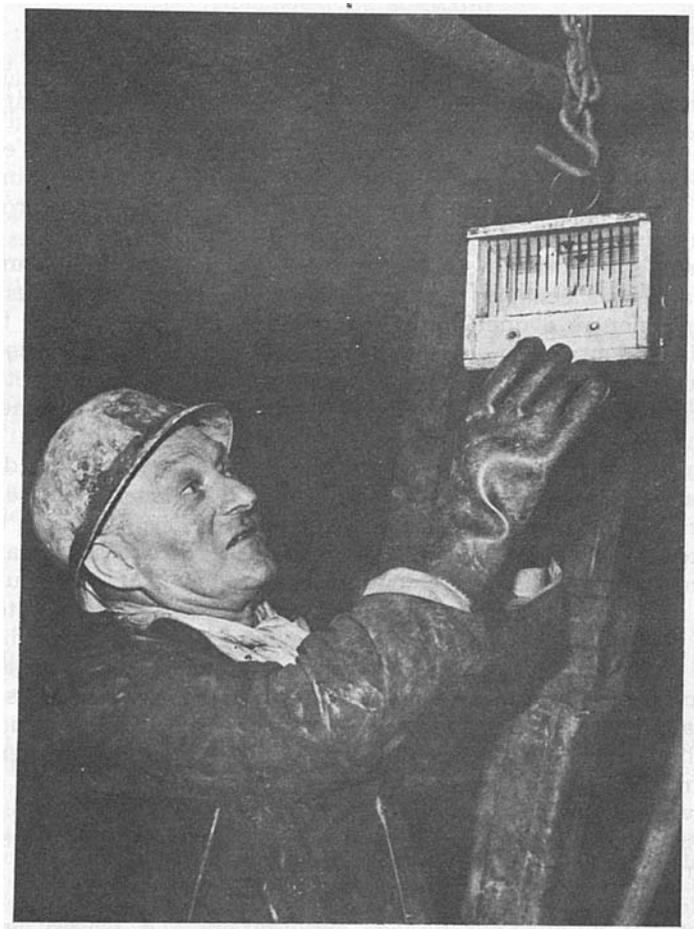
Mines de Sain Bel, la boîte au canari pour la détection de l'oxyde de carbone.
