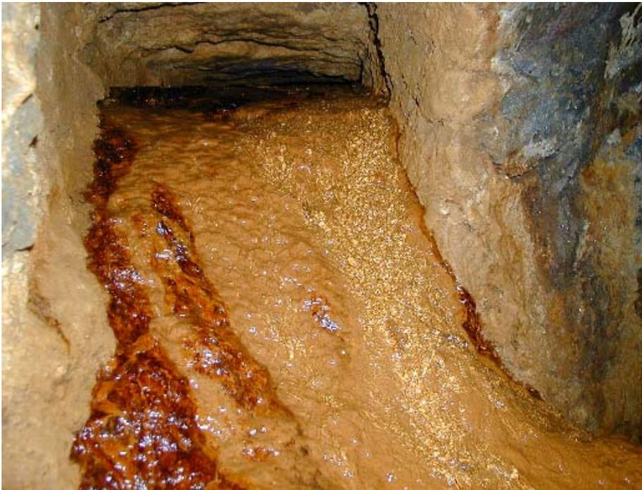
*Fig. 5 - Arrivée d'eau acide principale, galerie en cours de comblement.*
