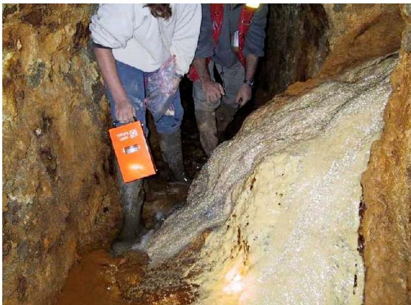
*Fig. 6 - Vue de côté, comblement de la galerie d'écoulement.*
