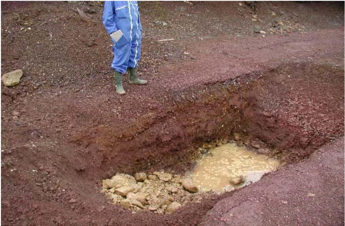
*Fig. 21 - Vue du drainage sous la pyrite.*
