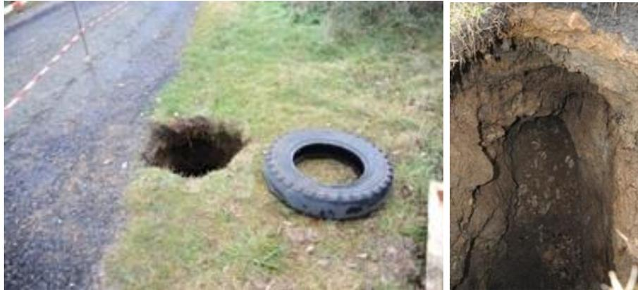
*Illustration 27 - Fontis à Lorlanges (1 m de diamètre environ et 3,5 m de profondeur).*
