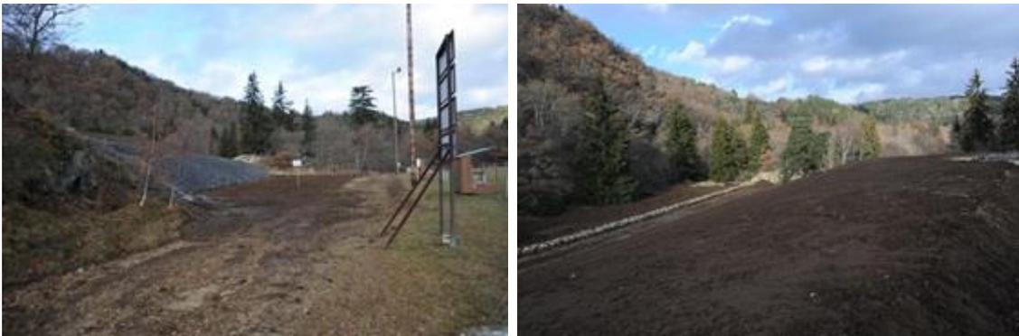
*Illustration 23 - Vue côté stade (à gauche) et côté Sioule (à droite) du chantier avec le merlon périphérique et la terre végétale.*
