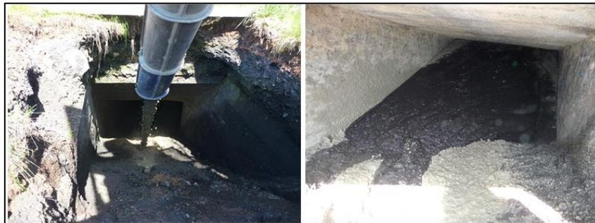
*Illustration 31 - Comblement du fond de l'ouvrage avec 8 m<sup>3</sup> de béton.*
