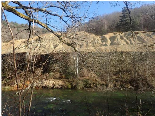
*Illustration 21 - Mur retenant le dépôt de résidus au bord de la Sioule.*
