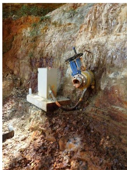
Illustration 131 : Tête du forage de contrôle recoupant la galerie G8 à Soyons (07).
