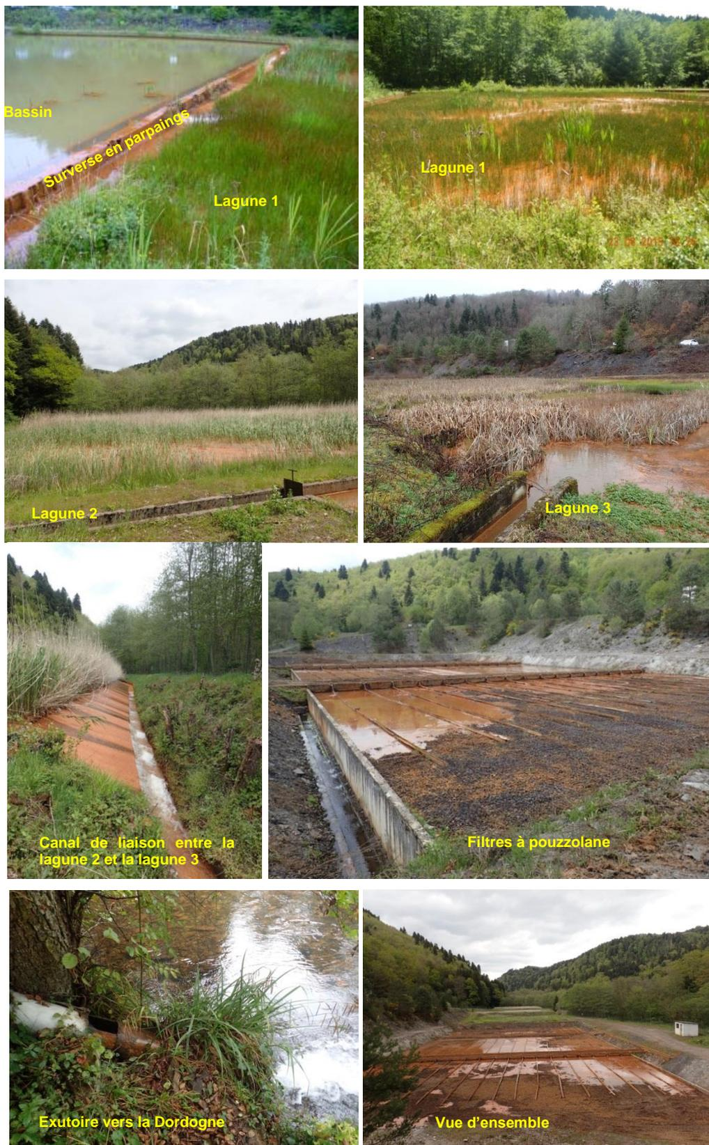
*illustration 71 : Messeix - Les principaux éléments assurant le fonctionnement de la station des Mouillères.*
