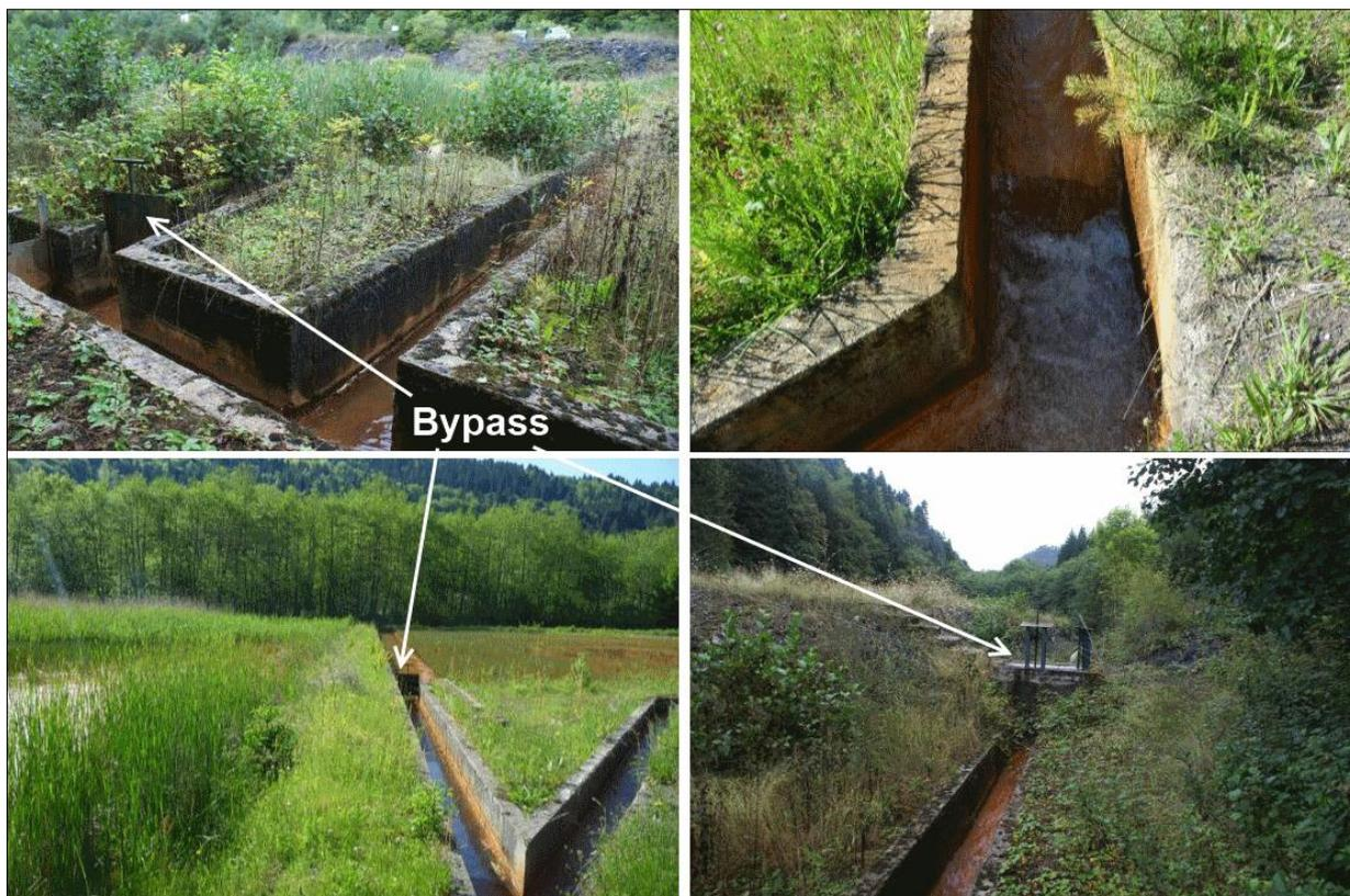
Illustration 70 : Messeix - Station des Mouillères - Les canaux de liaison et le système des bypass (2013).
