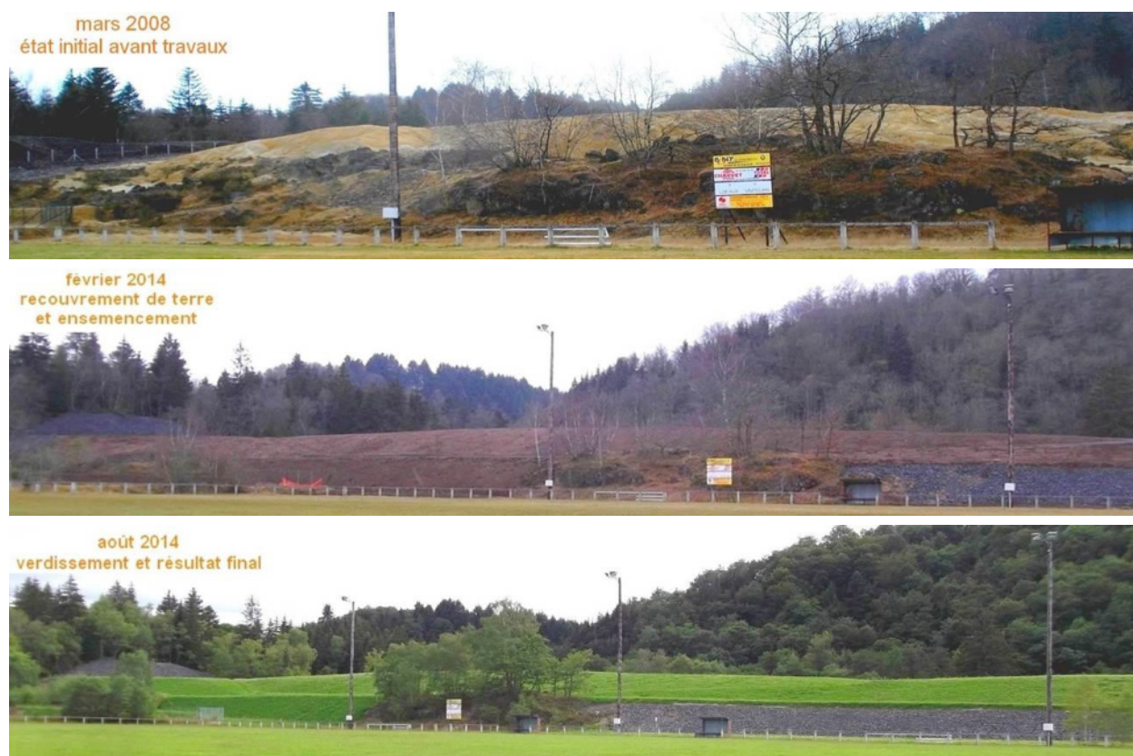
Figure II-11: Évolution du site « Les Fonderies » (principale unité associée à l'usine minéralurgique), Pontgibaud. Tiré de Pidon et al. (2016).
