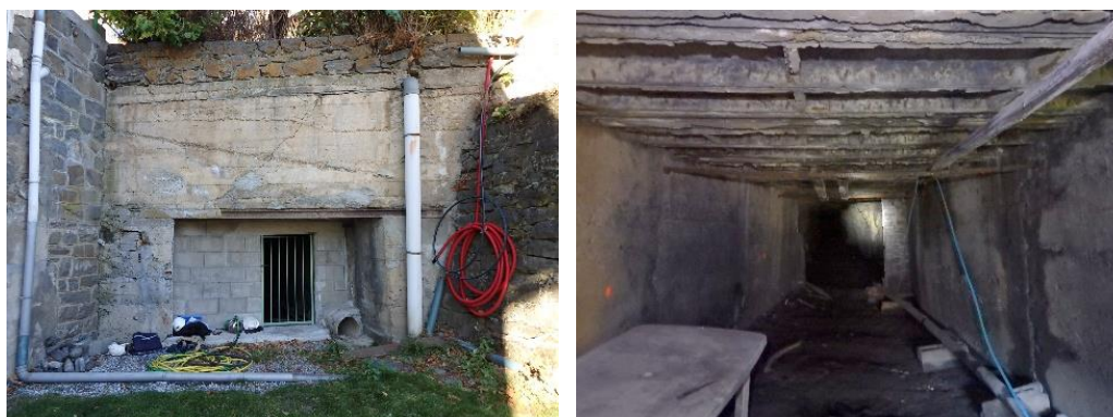
Illustration 49 : Galerie minière du TB Saint-Jacques aux Chapelles (73) - Entrée de la galerie après travaux d'aménagement (à gauche) et toit dégradé de la galerie sous la voie communale (à droite).
