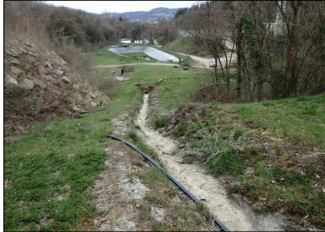
Illustration 34 : Dépôt de cendres de Côte Gravelle à Roche-la-Molière (42) - Réseau hydraulique au nord – nord-ouest (avril 2019).
