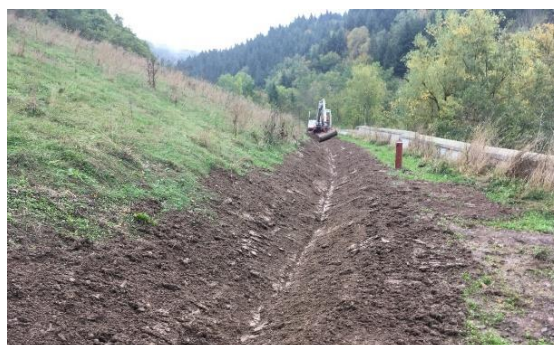
Illustration 100 : Fossé de risberme basse repris.
