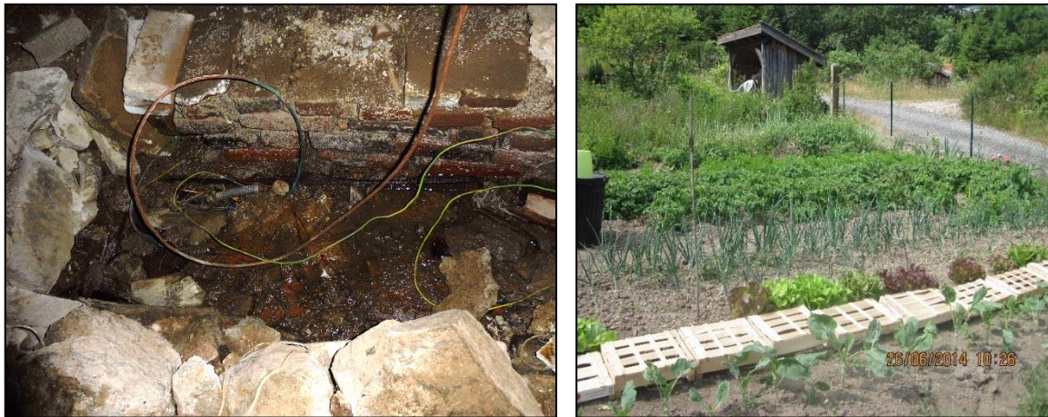
Illustration 41 : Maison sur dépôt du secteur minier de Saint-Martin-la-Sauveté (42) – Site du Taillis : vue d'une des caves avec écoulement pérenne (à gauche) et du potager (à droite).
