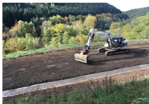
Illustration 102 : Reprofilage de la partie sommitale à la pelle mécanique.
