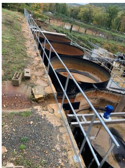
Illustration 43 : Travaux de sécurisation du mur de soutènement et installation d'un garde-corps (octobre 2019).
