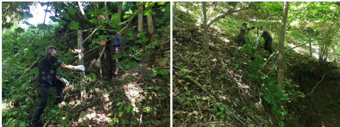
Illustration 73 : Mise en place des piquets sur Fournial 0 et fixation du grillage sur piquet en partie haute de Fournial 3.
