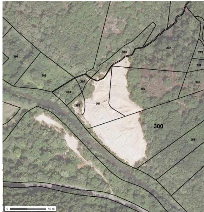
Illustration 96 : Vue avant travaux des dépôts de résidus de traitement de minerai de plomb argentifère de Barbecot (zones claires sur la photo) (source : geoportail.fr).
