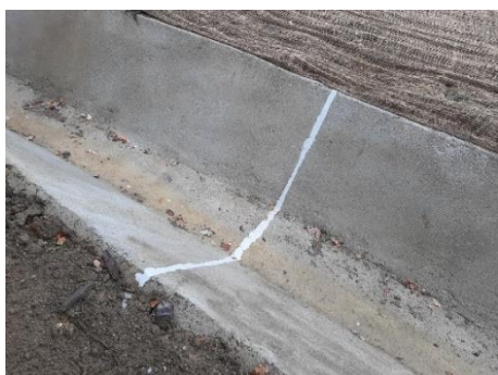
Illustration 99 : Traitement des joints de dilatation sur hydroband au Lankoseal.
