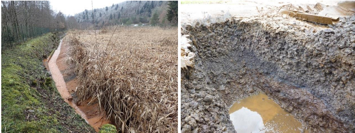
Illustration 87 : Messeix - Lagunes n° 2 et encrassement des filtres à pouzzolane (hiver 2018).
