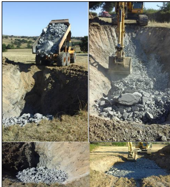
Illustration 68 : Remblaiement de la fouille.
