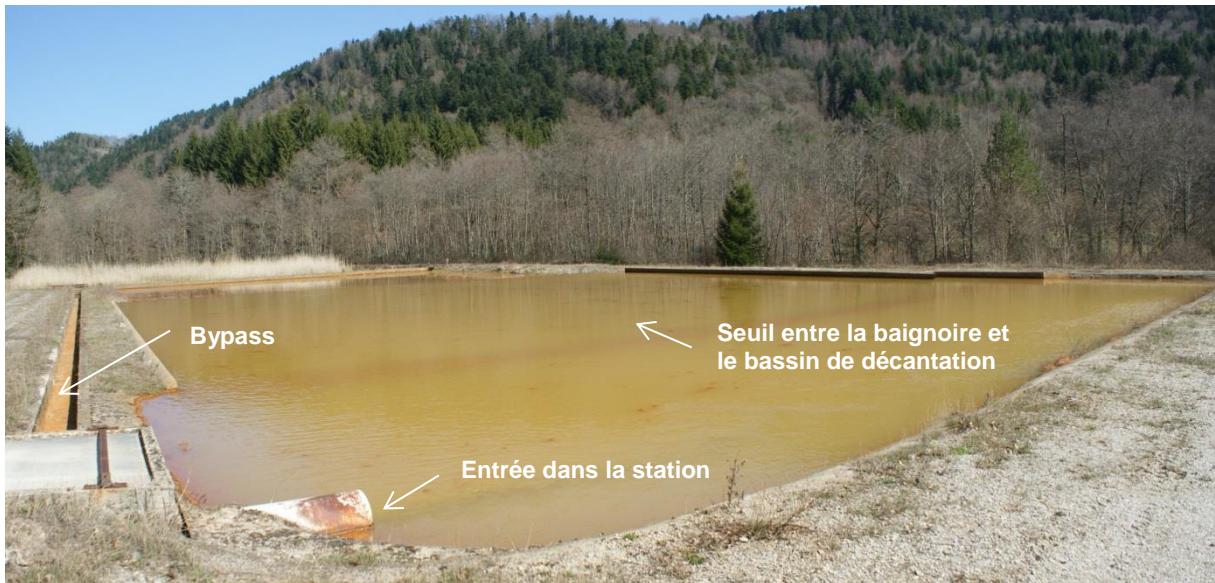
Illustration 85 : Messeix – Vue depuis l'entrée des eaux en station.
