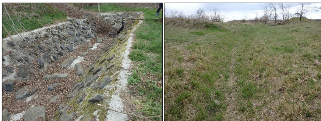
Illustration 33 : Dépôt de Côte Gravelle à Roche-la-Molière (42) - Fossé d'évacuation des eaux pluviales en partie sommitale (à gauche) et caniveau rejoignant le bassin d'orage (à droite) - avril 2019.
