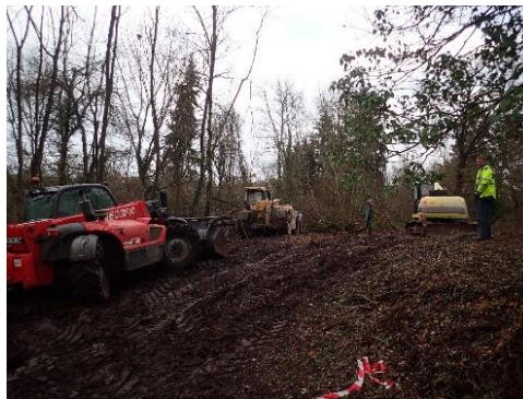
Illustration 61 : Accès au puits Saint-Michel.
