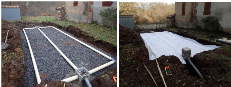
Illustration 64 : Circuit d'épandage et pose d'un géotextile.
