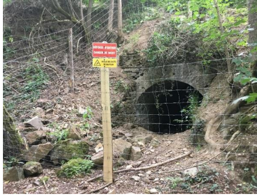
Illustration 74 : Passage à faunes rampantes sur Fournial 0.
