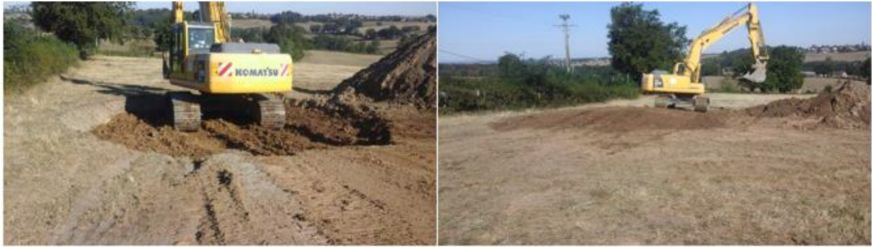
Illustration 69 : Compactage des matériaux (enrochement et terre) avec la pelle hydraulique et réalisation d'un tumulus.
