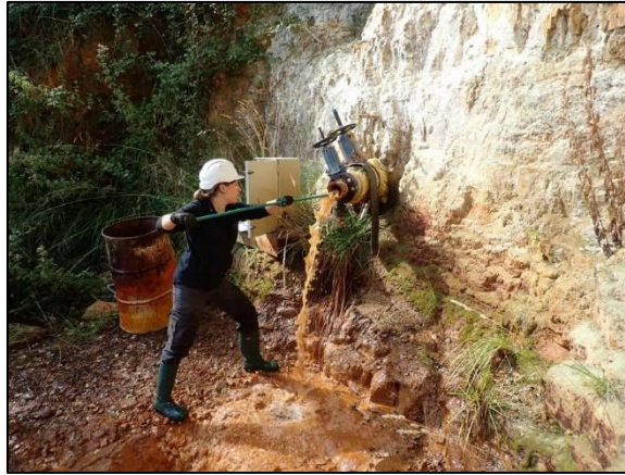
Illustration 5 : Ramonage du forage de la galerie G8 sur toute sa longueur (octobre 2019).
