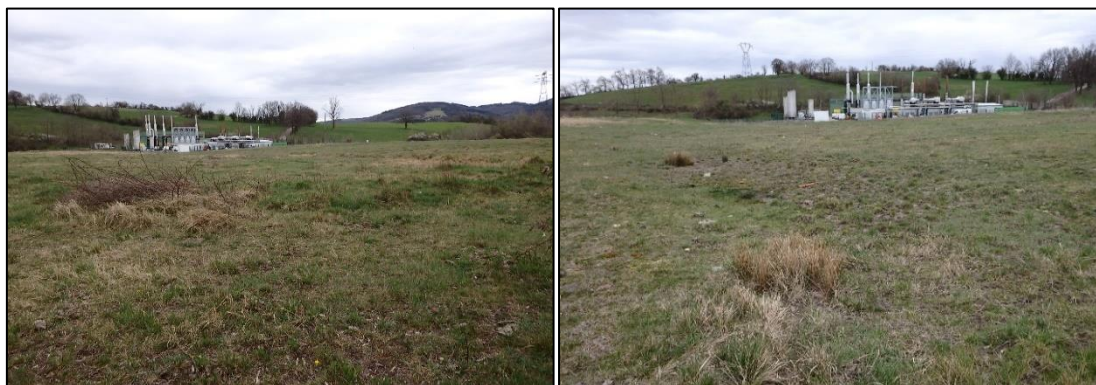
Illustration 32 : Dépôt de cendres de Côte Gravelle à Roche-la-Molière (42) - Point bas en partie sommitale montrant des signes d'accumulation d'eau (à gauche) et pacage de vaches (à droite) - avril 2019.
