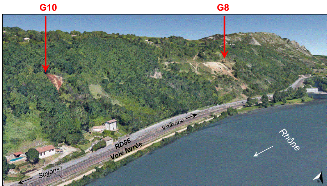
Illustration 4 : Vue aérienne de l'ancien site minier de Charmes-et-Soyons et localisation des galeries G8 et G10 (vue Google Earth).
