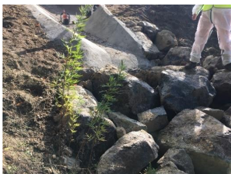
Illustration 101 : Enrochements sur géotextile pour ouvrage de dissipation.
