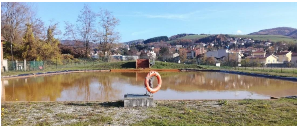
Illustration 17 : Station de traitement des eaux minières de Montrambert au Chambon-Feugerolles (42) - Vue générale du décanteur.
