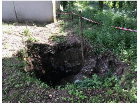
Illustration 60 : Photo du débouillage partiel du puits Saint-Michel.
