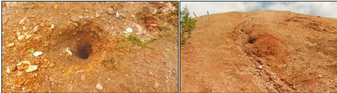
Illustration 22 : Terril Couriot A à Saint-Étienne (42) - Crevasse due aux échauffements souterrains (à gauche) et petite ravine au niveau du rampant (à droite) – prises de vue mai 2019.
