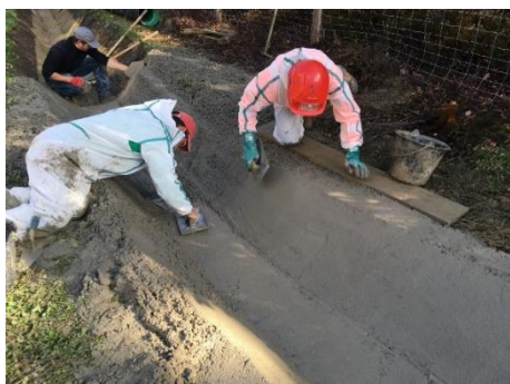
Illustration 97 : Coulage et façonnage du fossé B.
