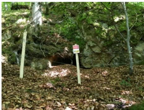
Illustration 76 : Type de sécurisation faite sur Fournial 10.
