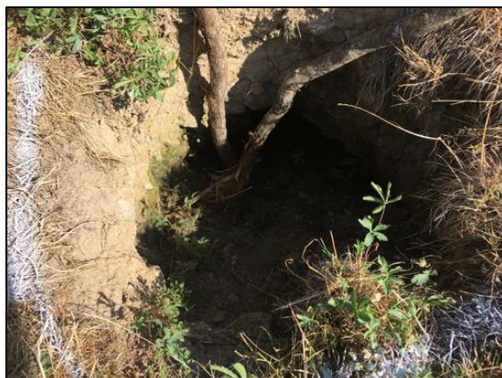
Illustration 66 : Bert - Fontis avant travaux.
