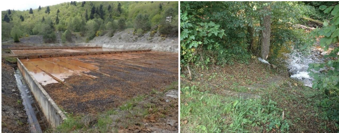
Illustration 86 : Messeix – Filtres à pouzzolanes (à gauche) et rejet en Dordogne (à droite).
