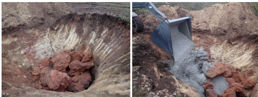
Illustration 63 : Mise en place et alliage des blocs d'enrochements dans du béton.
