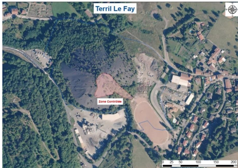
Illustration 24 : Vue aérienne du terril Le Fay à Saint-Jean-Bonnefonds (42) - Google Earth.
