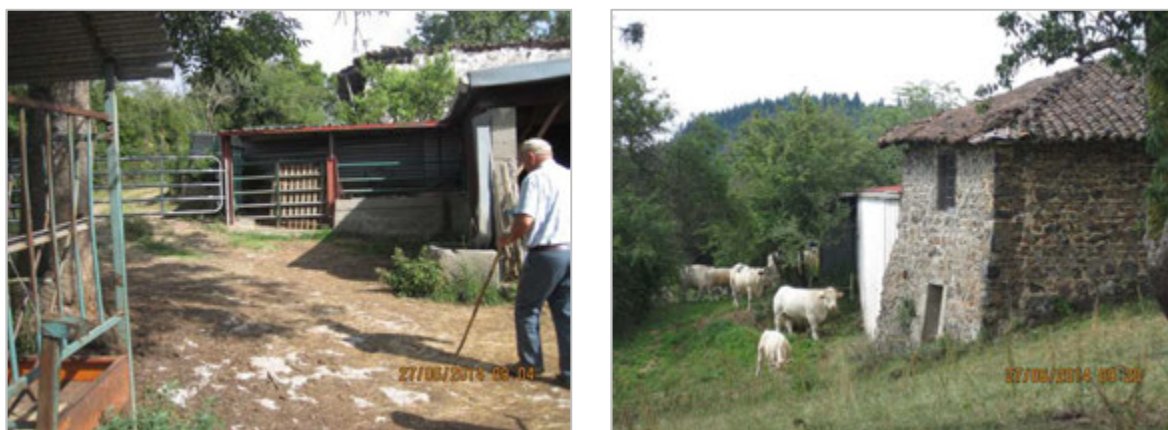
Figure 35 : Bâtiment agricole (INERIS, 2015)
