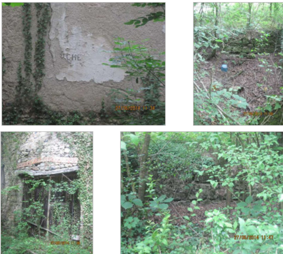
Figure 39 : Vestiges de bâtis miniers, supposés associés à une laverie rudimentaire (INERIS, 2015)
