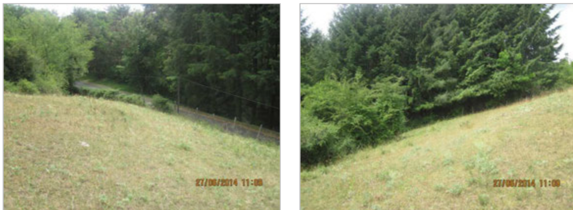
Figure 34 : Environnement immédiat du dépôt 42-0069-E-T1 (INERIS, 2015)
