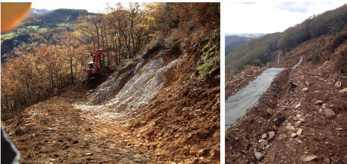
*Illustration 131 - Ancienne mine de tungstène d'Engualès au Fel (12) - Terrassement pour la mise en place de la clôture végétale (à gauche) bâche anticontaminante en toile tissée (à droite).*
