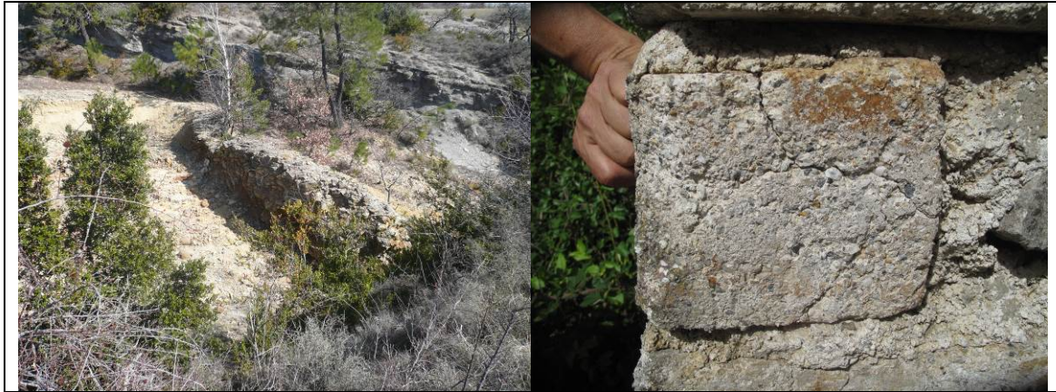
Figure 11 : Digue de pierre et brique contenant des résidus du dépôt
