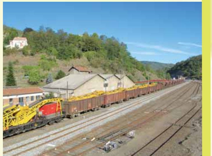
Le train de mise en place
