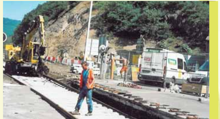
Lors du chantier, la réfection du passage à niveau
