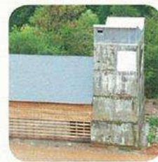
Ancienne tour de malaxage réhabilitée en abri à chauve-souris.
