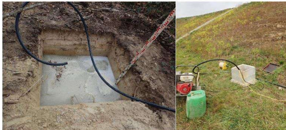
Illustration 13 - Vue de la fosse d'infiltration et du regard de pompage.
