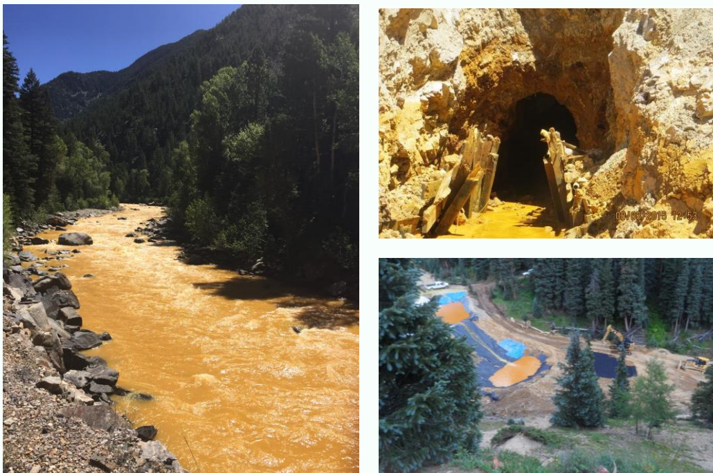
Figure 49 : Catastrophe de Gold King, Colorado, États-Unis, en août 2015 (à gauche) Rivière Animas entre Silverton et Durango (Colorado, États-Unis), 24 heures après le déversement des boues contaminées | Riverhugger · Août 2015 · cc by-sa 4.0 (à droite, en haut) Entrée de la galerie d'exhaure à l'origine de la catastrophe | EPA · Août 2015 · domaine public (à droite, en bas) Bassins de décantation construits suite au déversement | EPA · Août 2015 · domaine public
