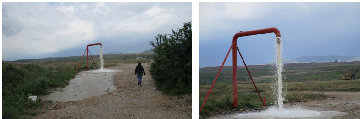
Figure 30 : Rejets d'eaux souterraines pompées à Akrini, Grèce | SystExt · Mai 2018 · cc b-sa-nc 3.0
