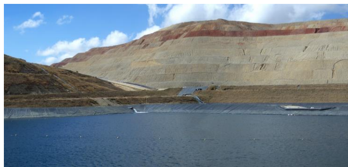
Bassin de collecte des eaux, en pied d'un tas | Euyasik · Août 2005 · cc by-sa 4.0
