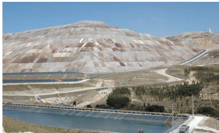
Tas, drains et bassins de collecte | Carlos Olivares · 2015 · cc by-nc 2.0
