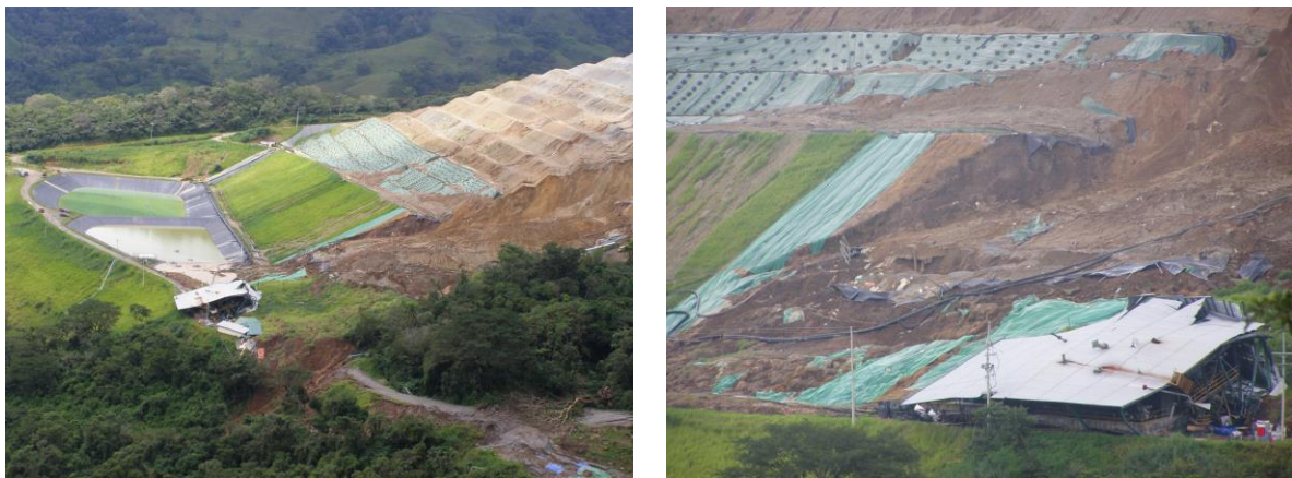
Figure 35 : Conséquences de l'effondrement d'un tas lixivié en 2007, mine d'or de Bellavista, Costa Rica | CEUS del Golfo · Janvier 2009 · cc by-sa-nc 2.0
