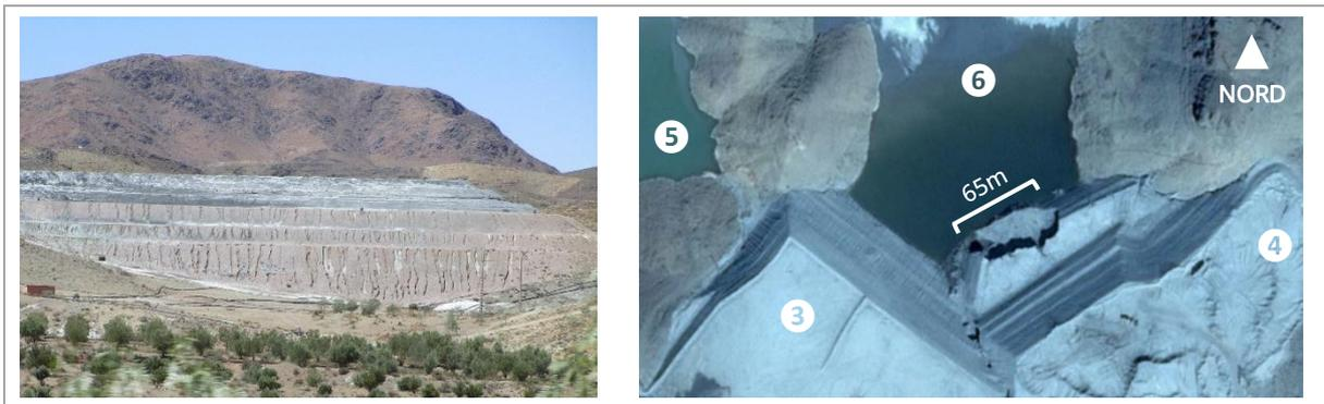
Figure 20 : Dommages sur les digues : à gauche : parc à résidus n°5, ravines profondes (SystExt, Avril 2019, CC BY-NC-SA 3.0 FR) ; à droite : parc à résidus n°6, glissement superficiel (© Google)<sup>49</sup>
